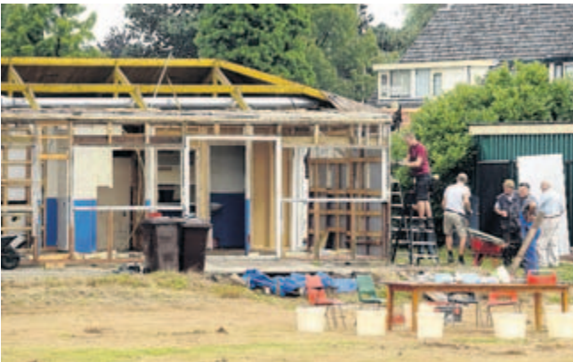
Ijsclub Otweg begon zaterdag met de sloop van het clubgebouw. Er komt een combibaan.
